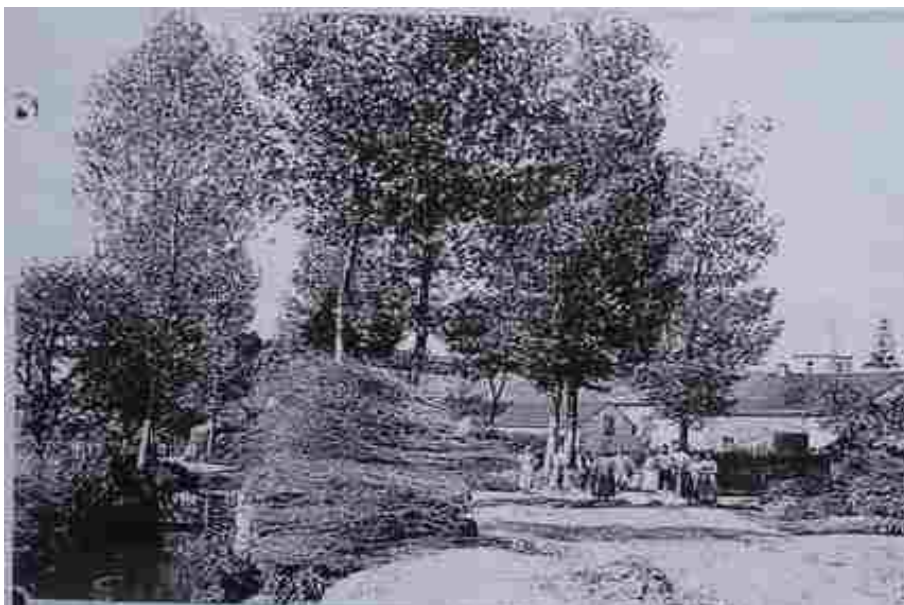
Carte postale (?) – travaux au bord du ruisseau
